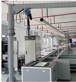
悬臂吊安装方案
